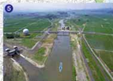
五泉市山崎地内
